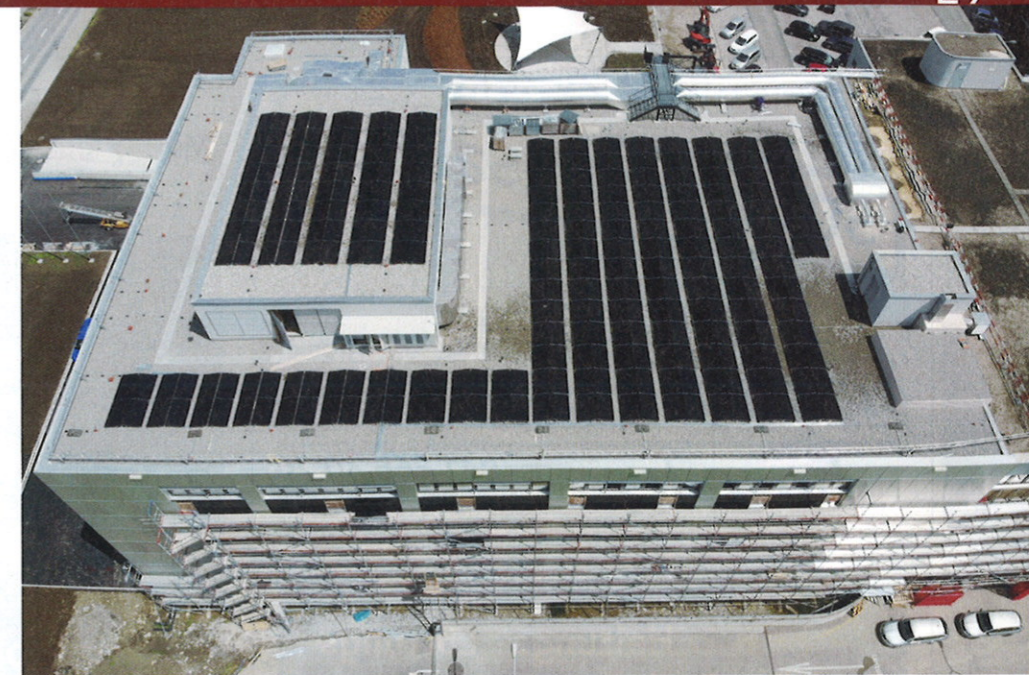
■ Luftaufnahme Leister Technologies AG mit neuer Photovoltaik-Anlage auf dem Dach. (Bild: Leister AG)
