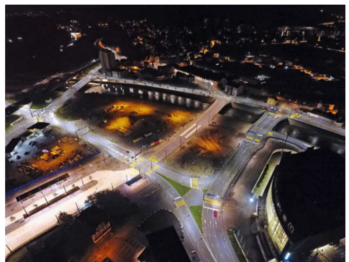
2 | Das Beleuchtungskonzept des Seetalplatzes. 2 | Le concept d'éclairage du Seetalplatz.
