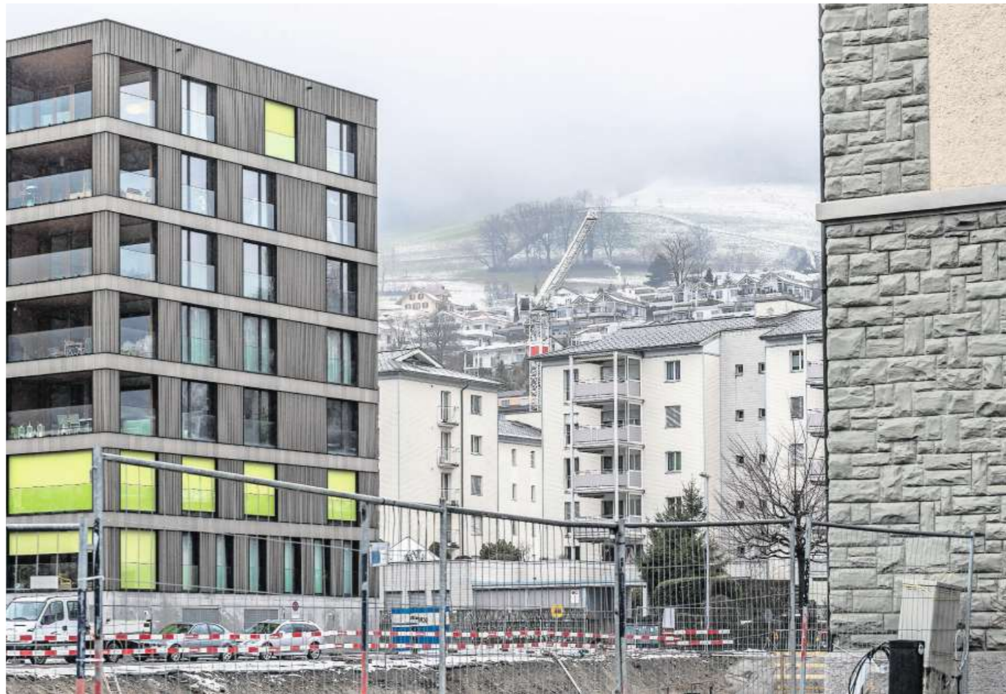
Vom Dorf ist zumindest optisch nur noch wenig übrig: Baustelle im Zentrum beim Gemeindehaus.
